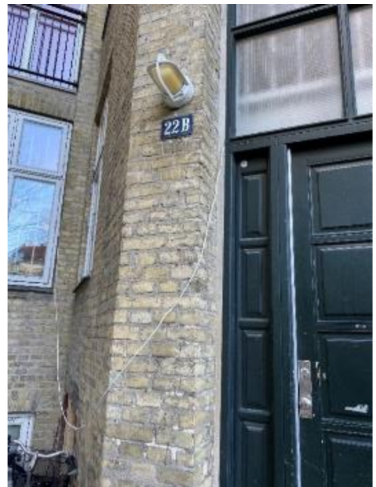
Belysningsarmatur placeret på facader ved døre til bagtrappeopgange.
