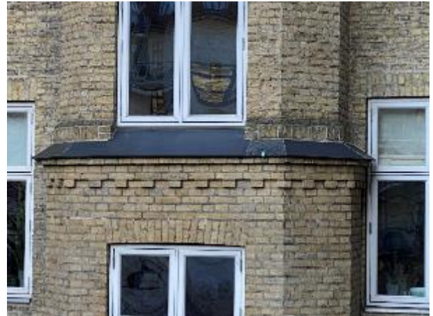
Sålbænke og gesimsbånd på gårdsiden er delvist udskiftet.
