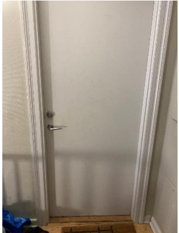
Nyere entrédør udført som massiv pladedør
