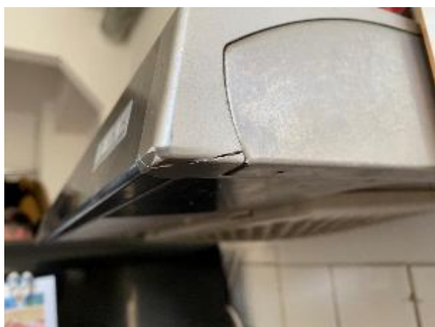
Krakeleret hjørne på emhætte
