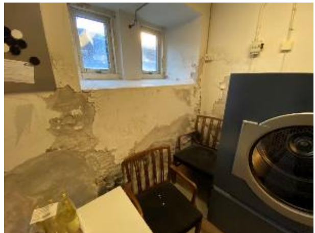
Nyere kældervinduer med enkeltfag og paskvilgreb set indefra.
