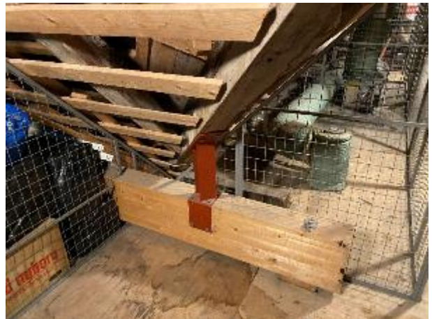
I forbindelse med byfornyelsen er kælbjælken blevet understøttet og oprettet
