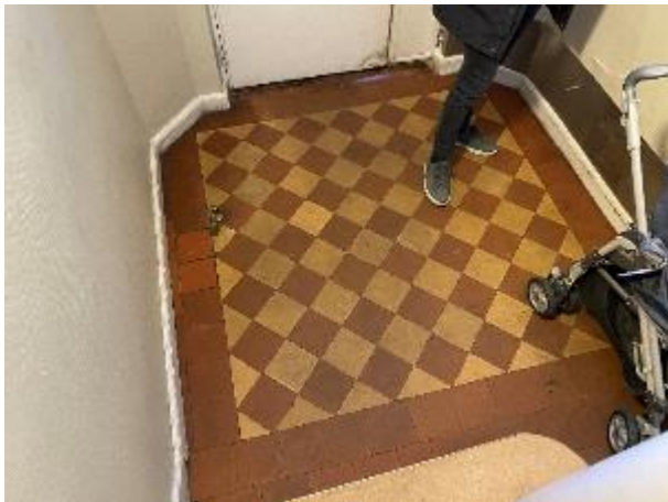
Flisebelægninger ved indgangsreposit.
