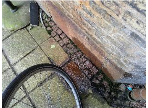
Samling mellem tagnedløb og fodbøjning er gået fra hinanden
