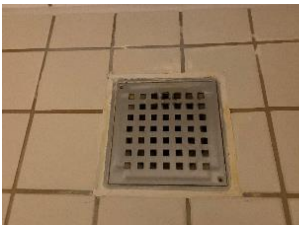
Udskiftet gulv afløb i 1999 med indbygningsvandlås
