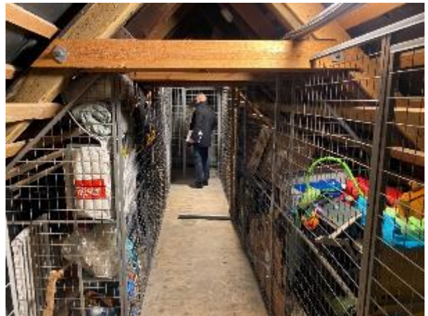
Tagkonstruktionen er blevet forstærket med påboltet tømmer (opretning) samt nye supplerende hanebånd.
