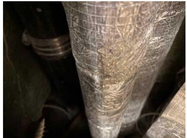
Faldstamme i installationsskakt (MA-rør) med jet-kobling ultra
