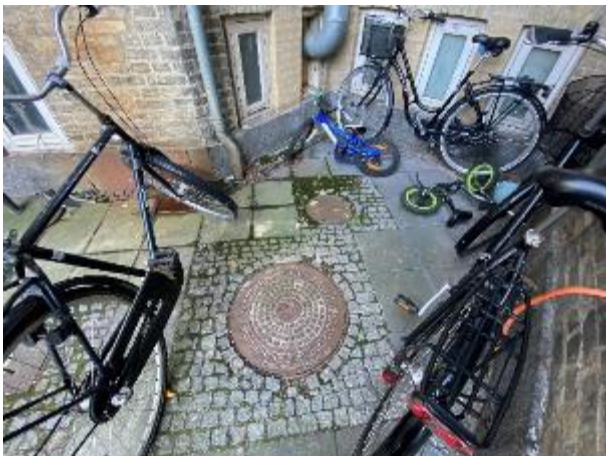
1M brønd i gård
