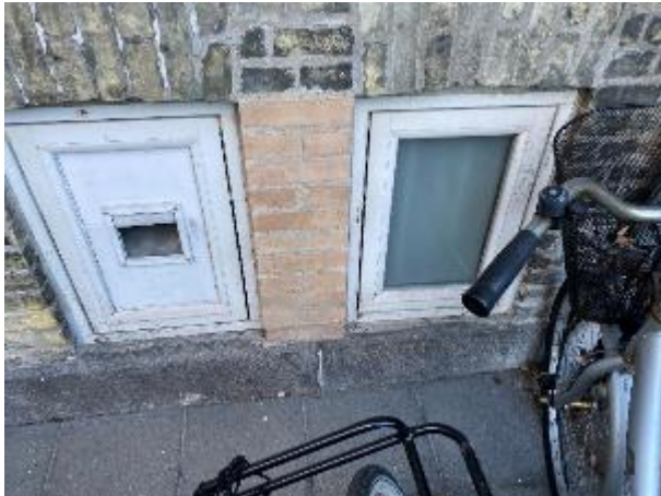
Ændringer i murværket tyder på, at størrelse og type af kældervinduer er ændret.
