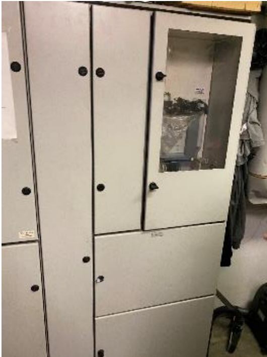
Hovedtavlen i varmecentralen.
