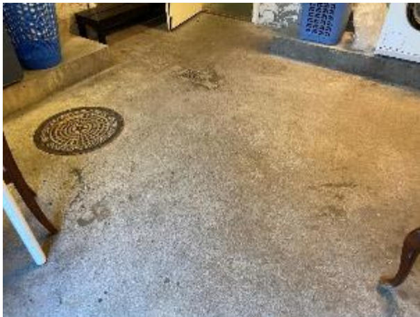
Terrændæk er udført i beton direkte udlagt på jorden. Der kunne ikke ses nævneværdige fugtskader eller tegn på oversvømmelser.
