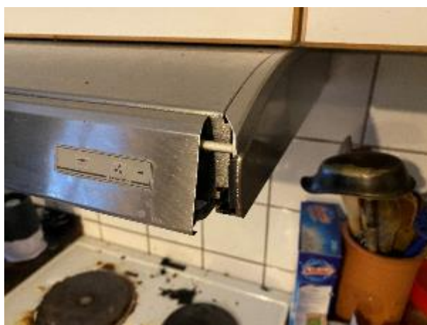
Ødelagt hjørne på emhætte
