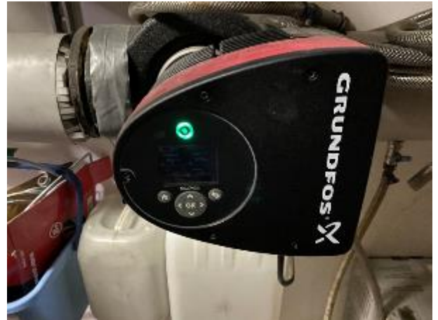
Cirkulationspumpe (trykreguleret) til centralvarmesystemet
