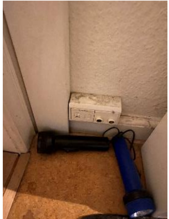
Et dataudtag som er tisluttet ejendommens bolignet system.
