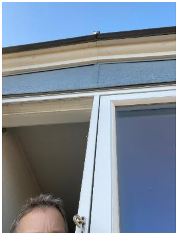
Over kviste er der udført et såkaldt "spejl" af falsset zink.
