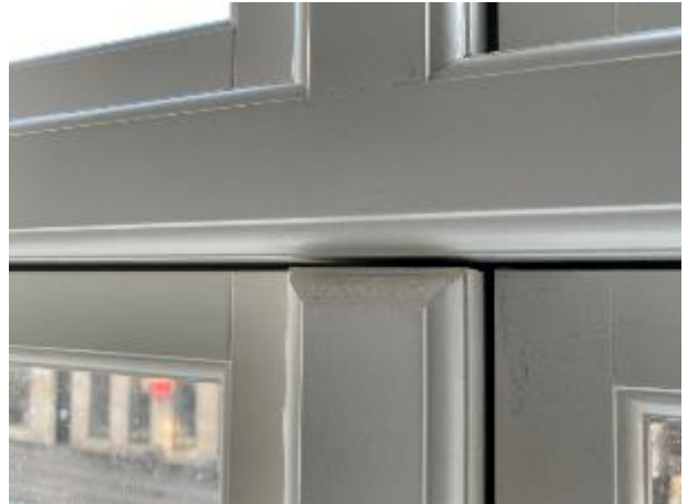
Vinduer er stedvis udført med gående lodrette poster hvor vinduerne skal virke som brandredningsåbning.
