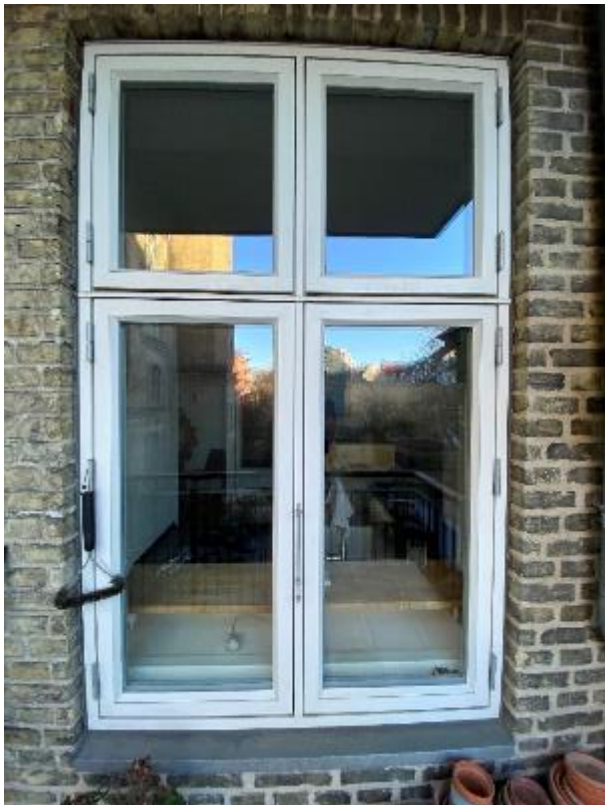
Vinduer til beboelse er overvejende udført som dannebrogselementer i træ/aluminium, med sidehængte eller sidestyrede rammer.
