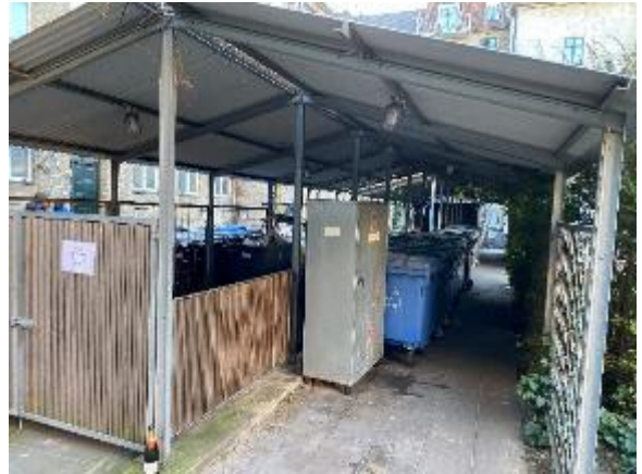
Der findes overdækket skralderum i gården, udført i galvaniserede stålprofiler og bølgeplader af stål som tag.
