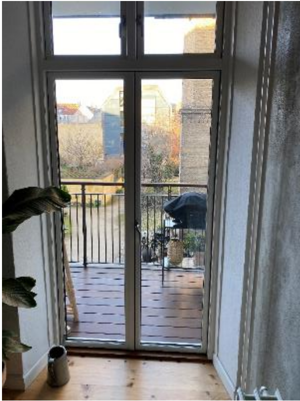
Elementer til nye altaner er overvejende udført i træ med energiruder, paskvilgreb og hårdtræsbundstykke.
