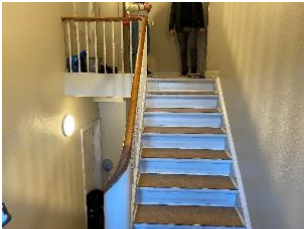
Håndliste er udført med svung – også ved øverste repos.
