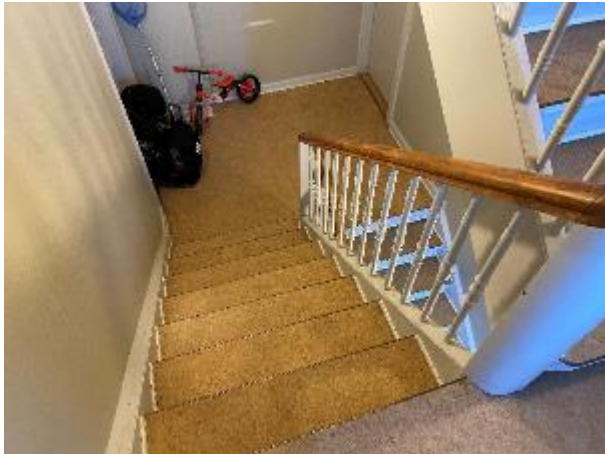
Gelænder til trapper er udført med malet træværk, drejede balustre og profileret lakeret håndliste.
