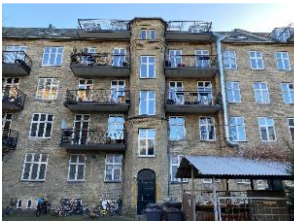
Der er monteret en del lette altaner på ejendommens gårdfacader i nyere tid.
