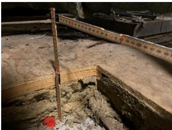
Der er efterisoleret på loftet med ca. 150 mm mineraluld.
