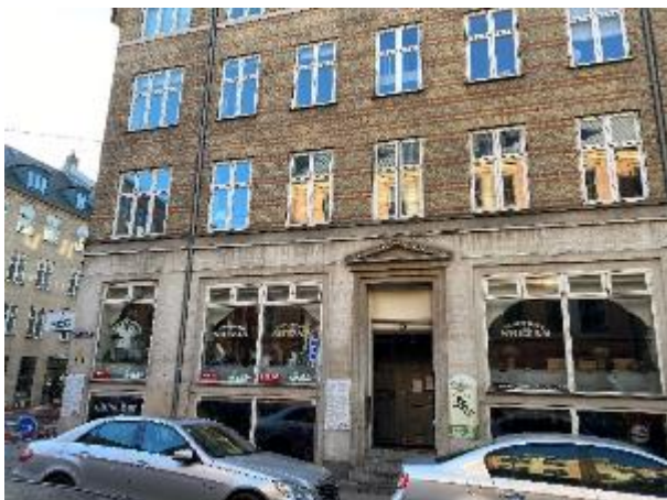
Facade mod gade, med pudset underfacade og blankt murværk på den øvre del.
