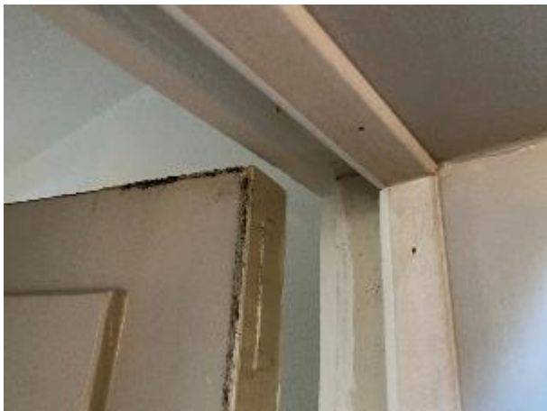
Entrédøre er stedvis forsynet med ekstra tætningslister for at sikre tætheden – både mod kulde, støj og brand.
