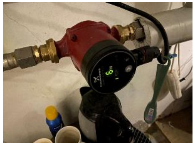
Nyere trykstyret cirkulationspumpe (brugsvand)
