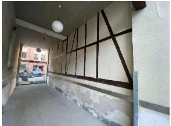
I portgennemgangen ses bindingsværket. Der er udført efterisolering af etageadskillelsen mod 1. sal, som er afsluttet med eternitplader.
