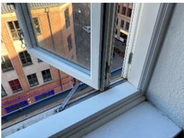
For at kunne pudse 1- og 3 fags vinduer udføres rammer stedvis sidestyrede, så man kan få en hånd ud på udvendig side.
