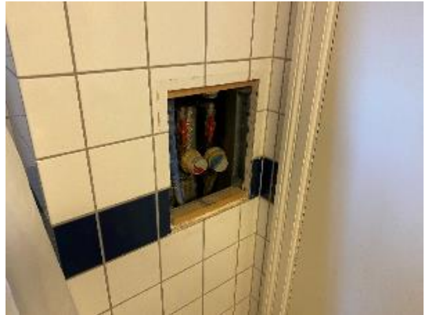
Stigstreng, fordelerrør og målere i installationsskakt
