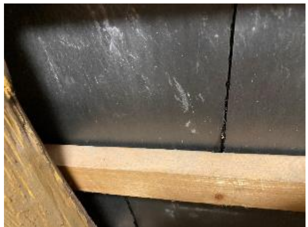
Tagbelægningen er udført med naturskifer lagt i kit uden undertag.
