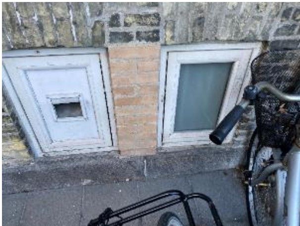
Kældervinduer er ændret, og i den forbindelse er der muret en søjle op.
