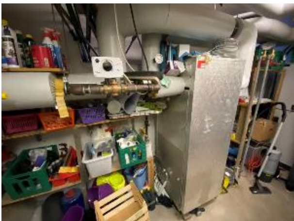
Pladevarmeveksler + motorventil til varmeveksler
