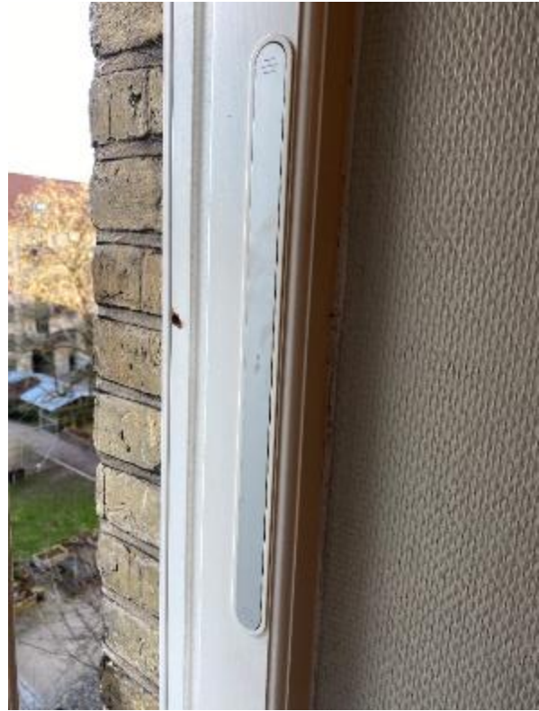
Vindue mod gårdsiden forsynet med spalteventil
